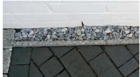
Bild 43 Beispiel für eine Fußpunktausbildung mit Kiesrandstreifen
