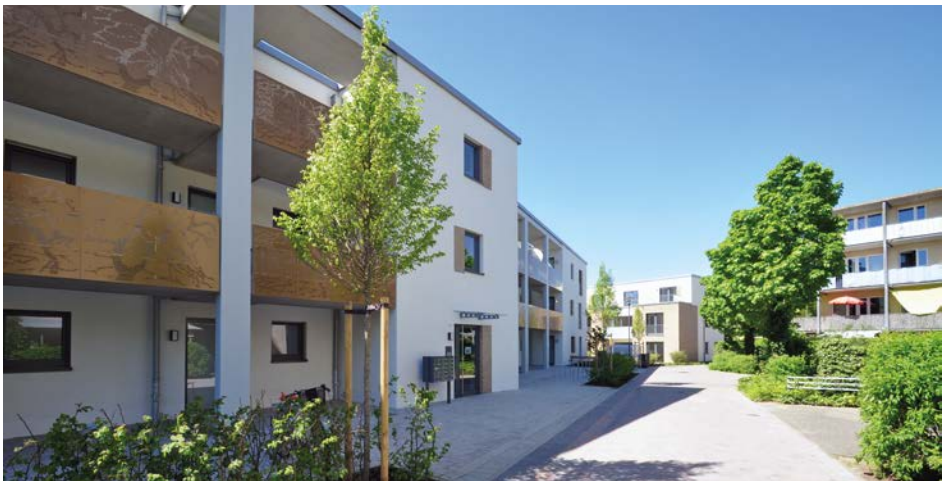
Bild 41 Zweischaliges Kalksandsteinmauerwerk mit verputzter Vormauerschale
