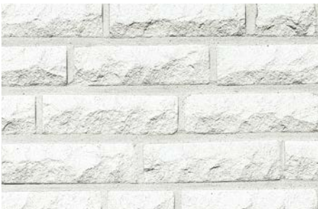
Bild 12 Sichtmauerwerk aus bossierten KS-Verblendern, Format NF, weißer Fugenmörtel
