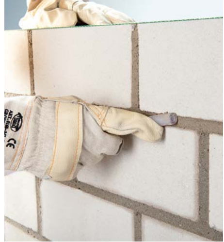
Bild 34 Der Fugenmörtel wird sauber mit einem Schlauchstück abgezogen.
