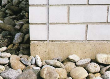
Bild 47 Dehnungsfuge an einer Gebäudeecke mit spritzbarem Dichtstoff
