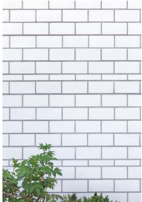
Bild 53 Die gestalterische Wirkung von handwerksgerecht hergestelltem Sichtmauerwerk ist zeitlos.
