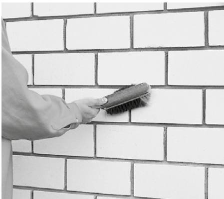
Bild 31 Eventuell vorhandene Mörtelreste sind abzufegen.
