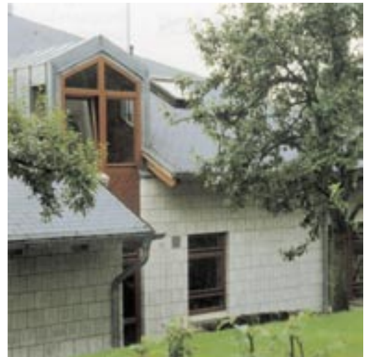
Bild 1: Kalksandstein-Fassade mit Verblendern
