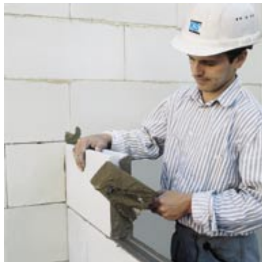
Bild 21: Stumpfstoß einer leichten Trennwand aus KS-Bauplatten
