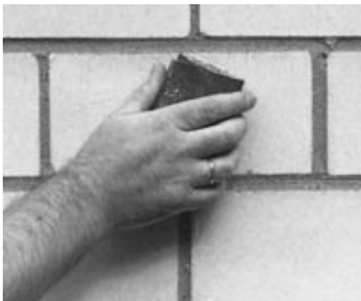
Bild 49: Schonende Reinigung mit Sandpapier, feinste Körnung
