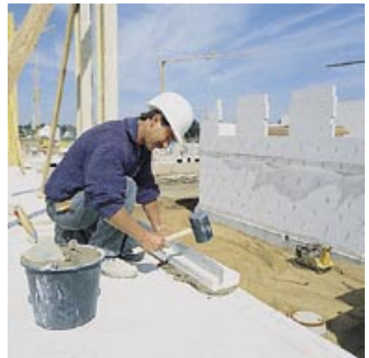
Bild 19: Die Kimmschicht, mit KS-Kimmsteinen einfach anzulegen
