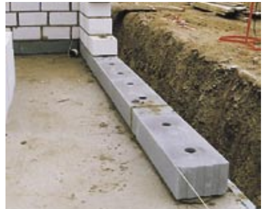
Bild 25: Anlegen der Kimmschicht mit dem KS-ISO-Kimmstein
