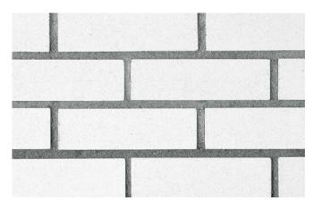
Bild 1 Sichtmauerwerk aus glatten KS-Verblendern im Format NF
