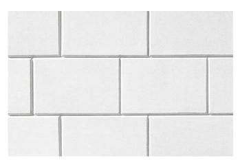
Bild 4 Sichtmauerwerk aus KS-Fasensteinen, außen in Verblenderqualität und mit vermörtelten Stoßfugen
