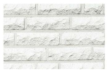
Bild 3 Sichtmauerwerk aus bossierten KS-Verblendern, Format NF, weißer Fugenmörtel
