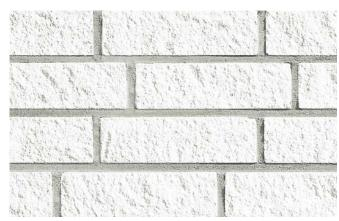
Bild 2 Sichtmauerwerk aus bruchrauen KS-Verblendern, Format NF
