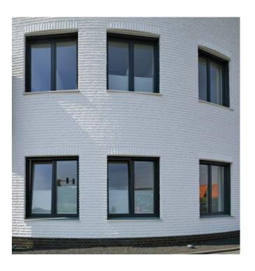
werden in deutlich geringerem Umfang in die Poren der Steine eingespült, sie werden vielmehr vom Regenwasser fortgespült. Damit ist ein gewisser Selbstreinigungseffekt verbunden.
