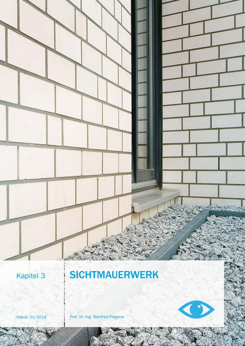
KS-Sichtmauerwerk mit glatter oder strukturierter Oberfläche bietet eine Fülle von gestalterischen Möglichkeiten, speziell auch in Kombination mit anderen Baustoffen, wie Holz, Glas und Beton. Das feine Fugennetz gliedert die Sichtmauerwerksflächen maßstäblich und unaufdringlich. KS-Sichtmauerwerk kann unbehandelt bleiben, farblos imprägniert oder deckend gestrichen werden.
