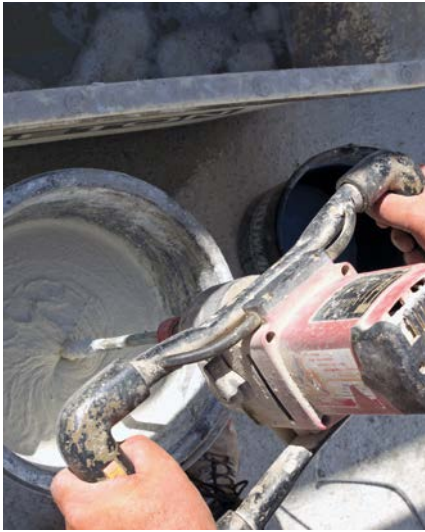
Bild 2 Anmischen von Dünnbettmörtel
