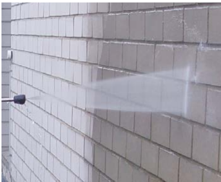
Bild 29 Reinigen mit Dampfstrahlgerät
