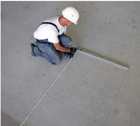
Bild 3 Die Festlegung der Lagerflächen für die Kalksandsteine erfolgt rechtzeitig vor Anlieferung des Materials.
