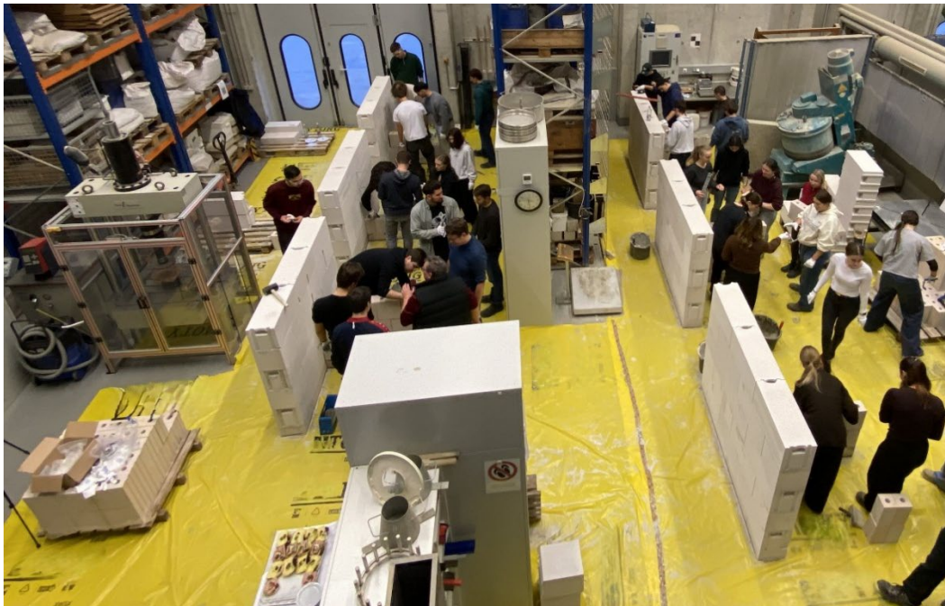
Abb. 2: Das Mauern der KS-Wand
