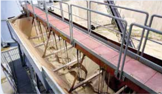
Die Aufbereitung der Sande erfolgt durch Zyklone, Freifallklassierer, Schöpfräder, Aufstromklassierer oder Entwässerungssiebe. Abgebildet ist ein Freifall- bzw. Sandklassierer, der aufgrund von Wartungsarbeiten trockenengefallen ist. Der Sand im Sand-Wasser-Gemisch setzt sich in Abhängigkeit von der Nähe zur Aufgabe von grob nach fein in den hintereinander angeordneten Kammern am Tankboden ab und kann dort über eine Schleuse ausgetragen werden, Foto: BGR.
