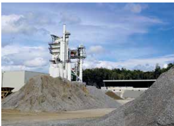
Asphaltmischwerk in Amtzell-Grenis im Allgäu. Hier werden in einem benachbarten Kieswerk hergestellte Edelkiessplitt- und Edelbrechsande, aber in großem Umfang auch Asphalttrezyklate zur Asphaltmischgutproduktion eingesetzt, Foto: BGR.
