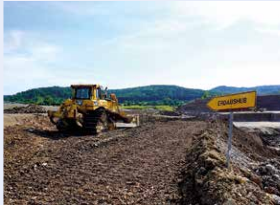
In Süddeutschland dient selbst stark kiesig-steiniger Bodenaushub häufig nur zur Verfüllung von Trockenabgrabungen und stellt dabei eine wichtige Einnahmequelle der Abbaunternehmen dar, Foto: BGR.
