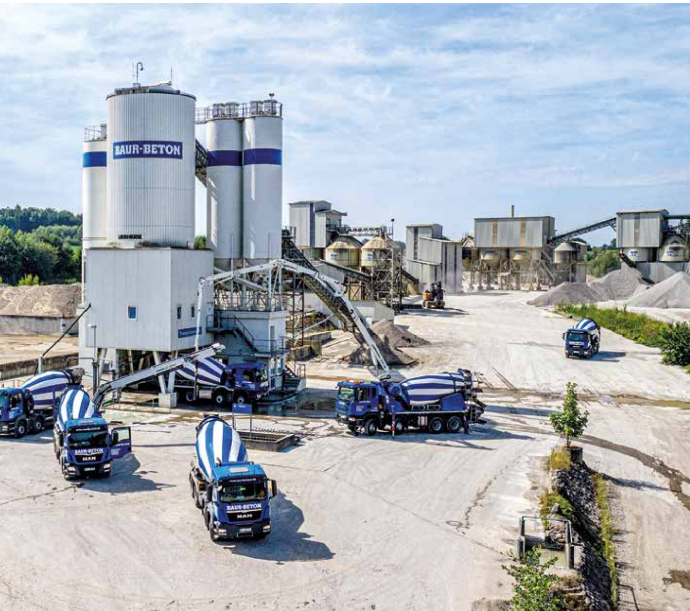
Auf Werksgeländen von vielen Kieswerken in Deutschland ist auch ein Transportbetonwerk zu finden, das bei sehr kurzen Transportwegen bereits einen Großteil der produzierten Gesteinskörnungen verwendet. Foto: Martin Baur GmbH (mit frdl. Genehmigung).
