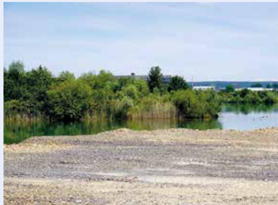
Bei öffentlichem Interesse, besonders bei Vogel-schlaggefahr nahe von Flughäfen, ist in ganz Deutschland die Verfüllung mit unbelastetem Bodenaushub auch von Nassabgrabungen zulässig. In der Nähe dieser Abgrabung in Nordbayern liegt allerdings nur ein Segelfluggplatz, Foto: BGR.
