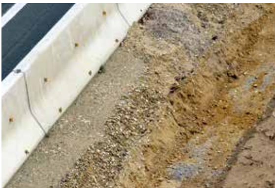
In praktisch allen Straßen-, Wege- und Eisenbahnbaumaßnahmen in Deutschland wird Mineralgemisch 0/32 mm verwendet, hier als Tragschicht beim Ausbau der A3 in Nordrhein-Westfalen, Foto: Walter Nelles (mit frdl. Genehmigung).
