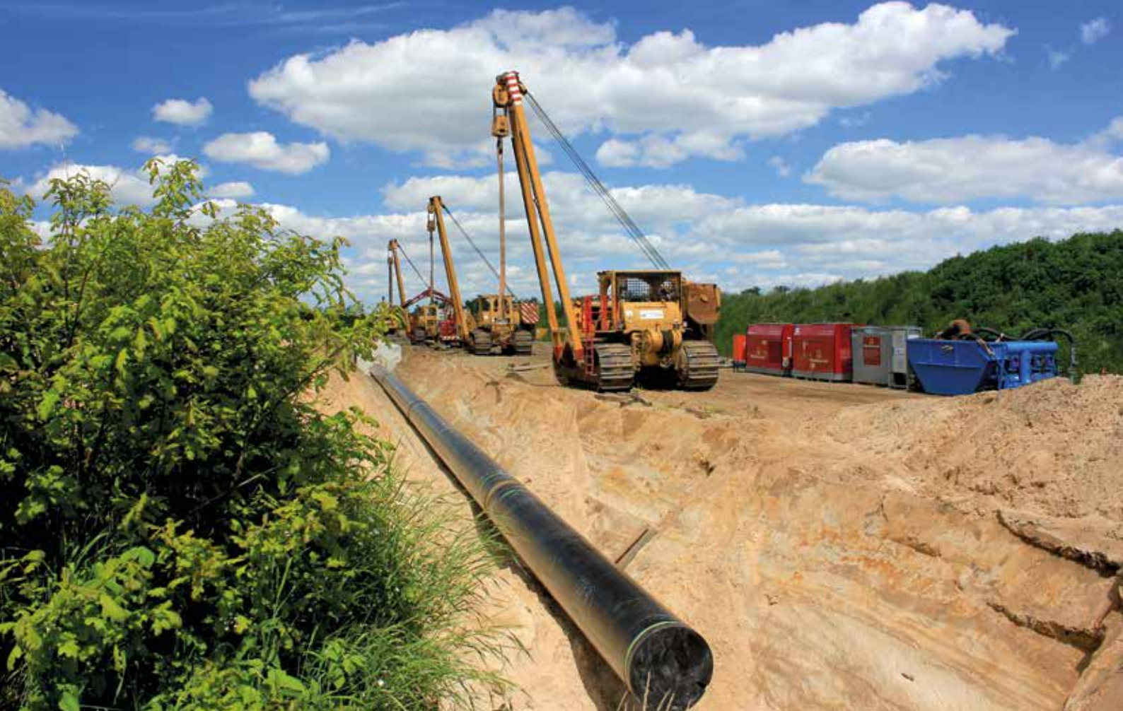
Unterirdisch verlegte Rohre, wie diese Erdgasrohre, werden zum Schutz vor abschließender Auffüllung des Grabens mit „Kabelsand“ 0/1 mm ummantelt, Foto: Andreas Wittmar (mit frdl. Genehmigung).
